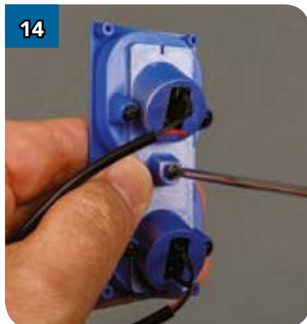
14 ...и соедините их фланцевым винтом 2 x 6 мм.
